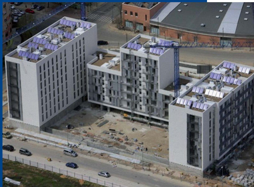
En las azoteas del edificio están instaladas las placas solares que favorecen el ahorro energético.
